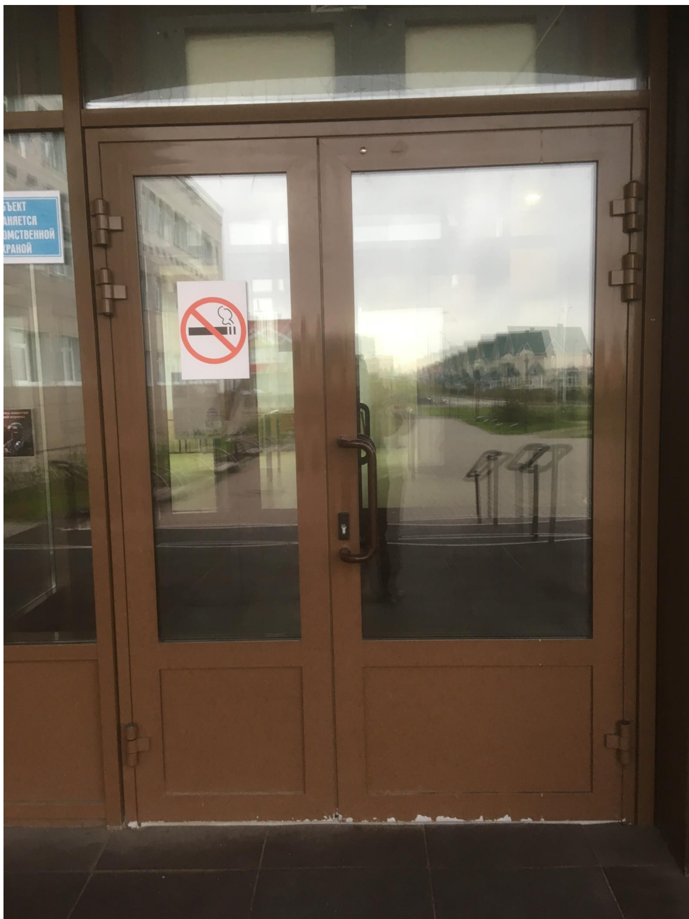
Фото №11 Дверь входная
