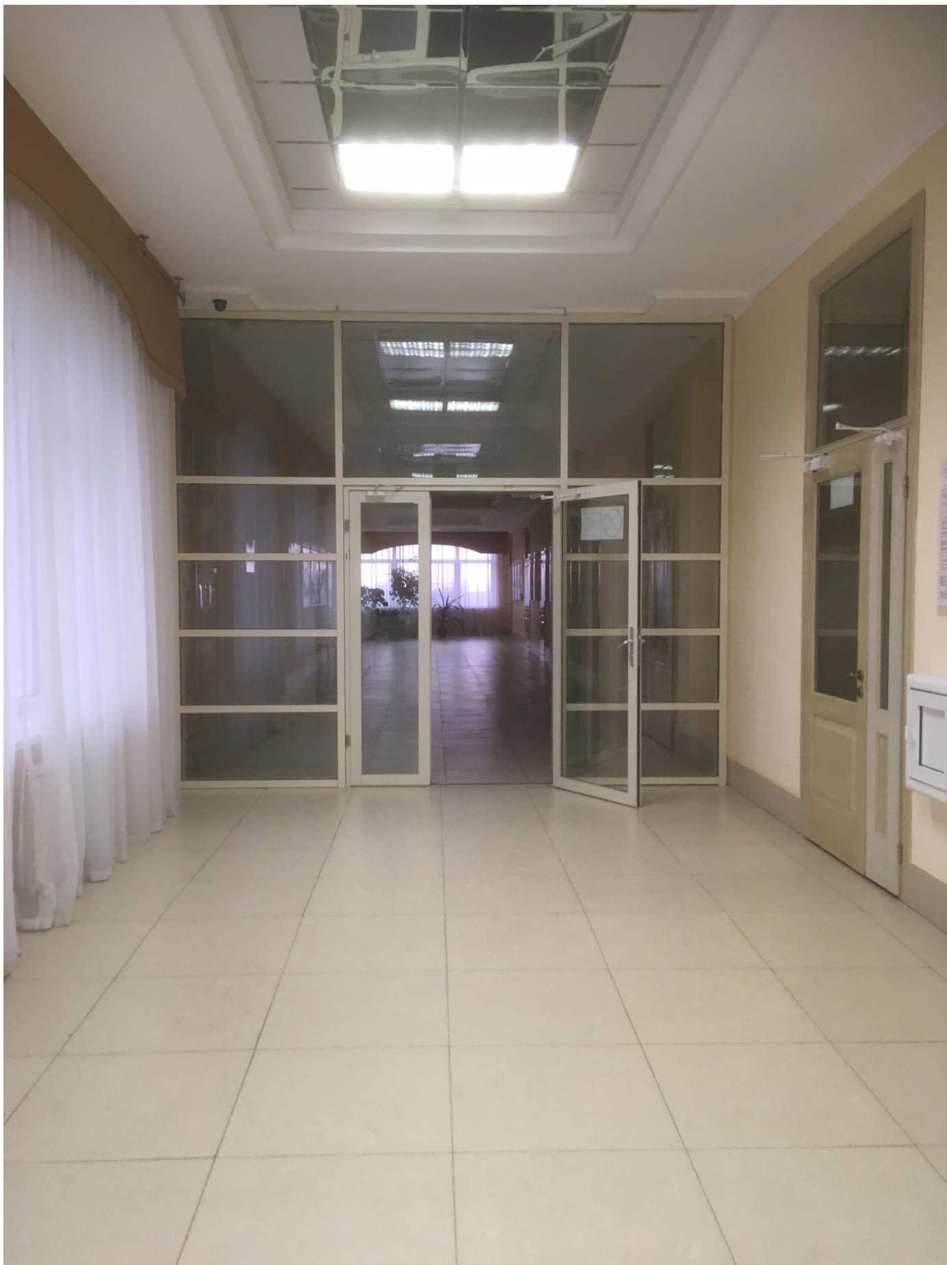
Фото №24 Пути эвакуации
