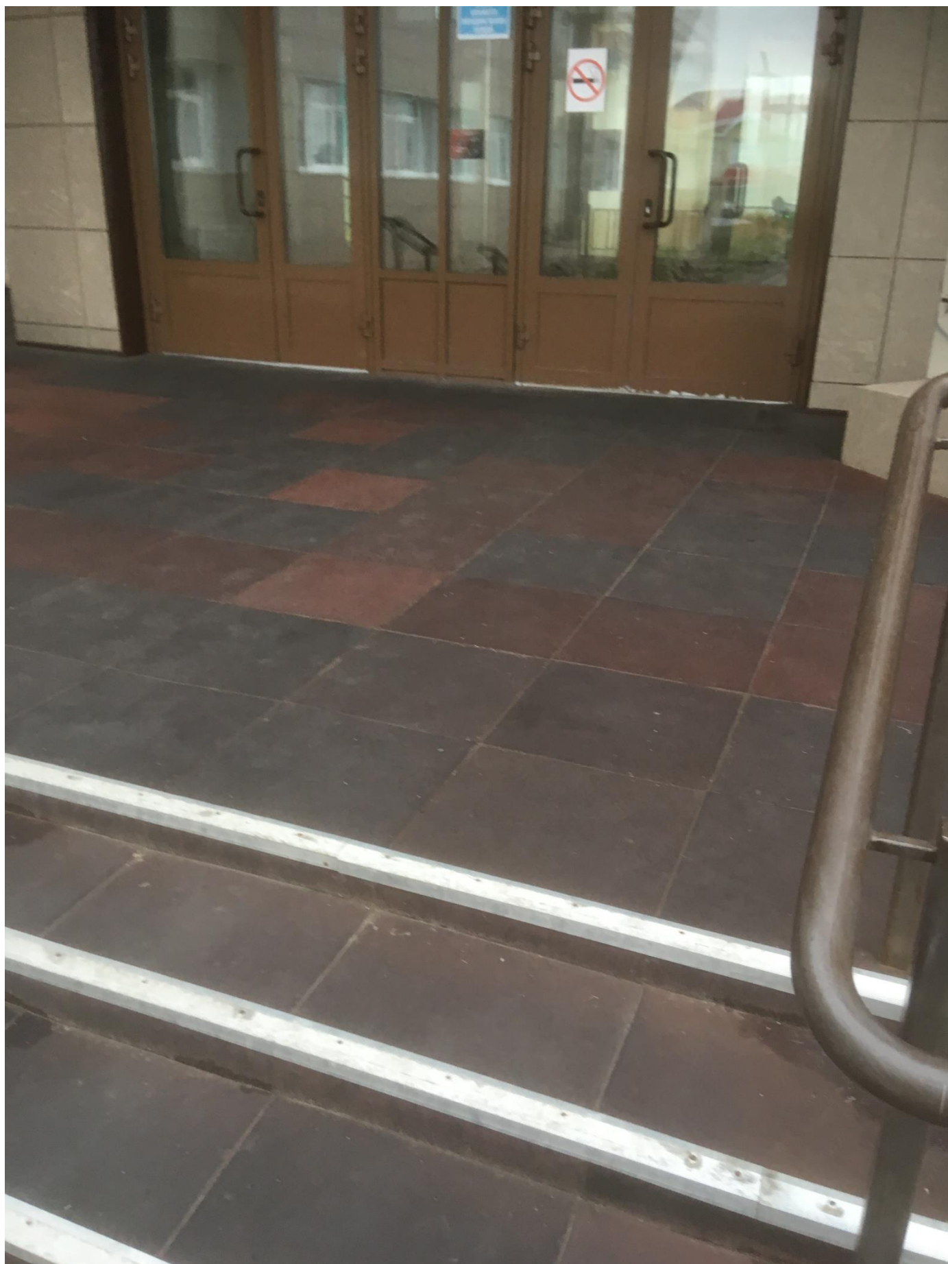
Фото №10 Входная площадка перед входной дверью
