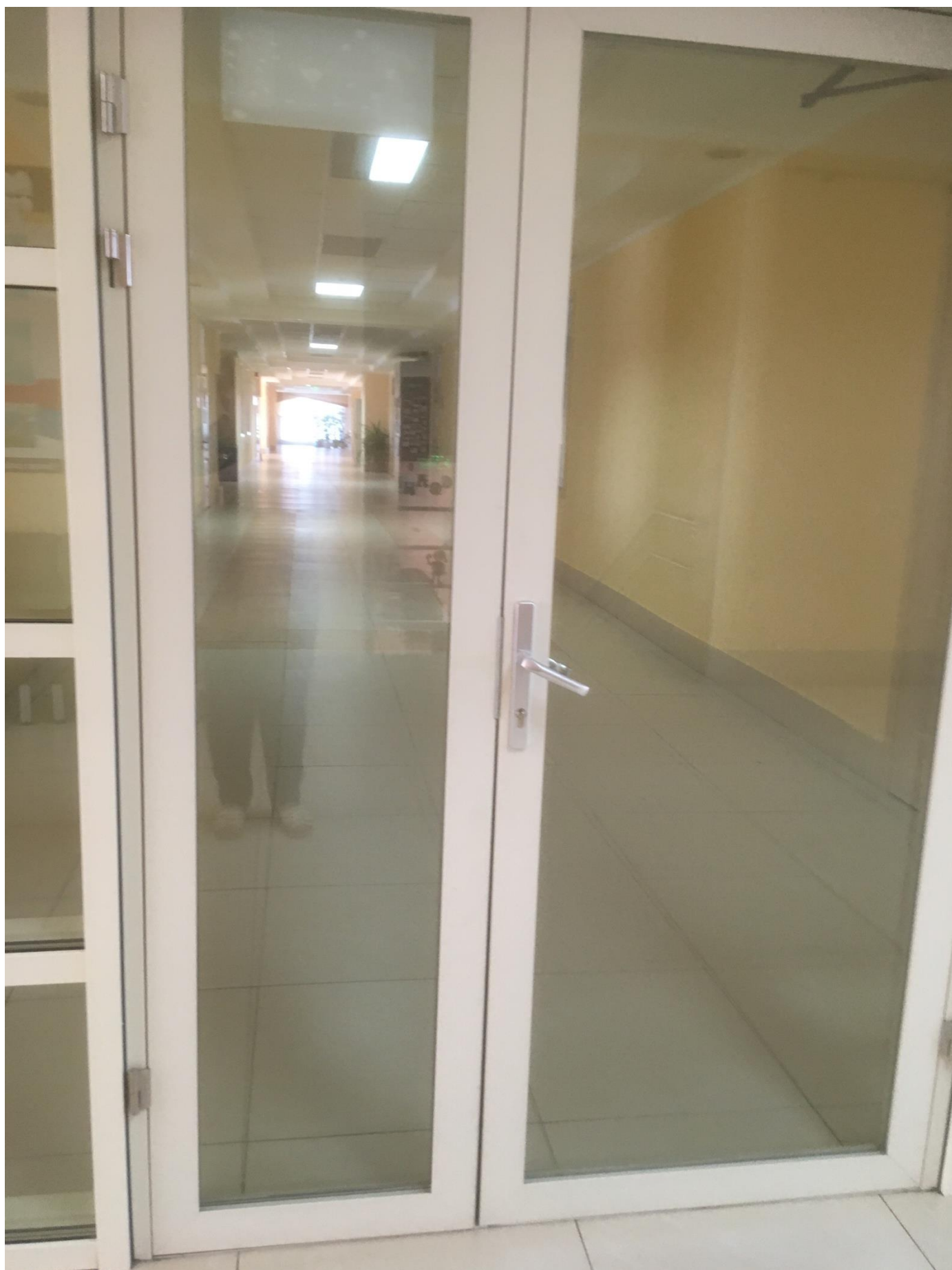
Фото №20 Пути эвакуации
